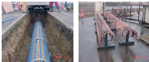
Рисунок 7. Система укладки теплообменника расположенная вдоль канализационных труб
